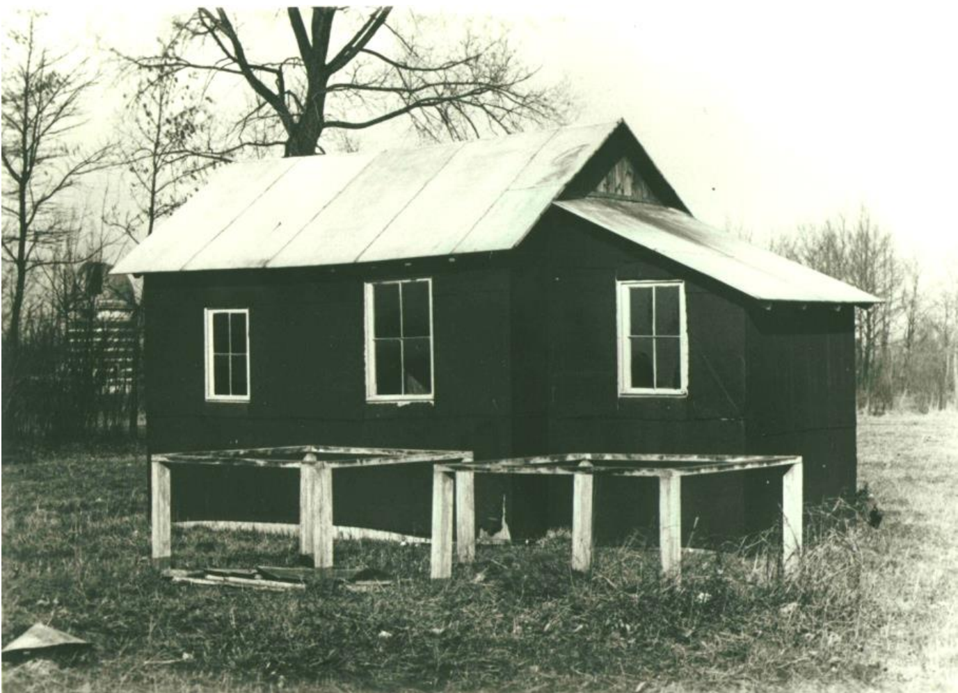
Premier pavillon (1898-1908) au dessus de la cave contenant les premiers instruments. Eerste paviljoen (1898-1908) boven de kelder waarin de eerste instrumenten waren geïnstalleerd.
